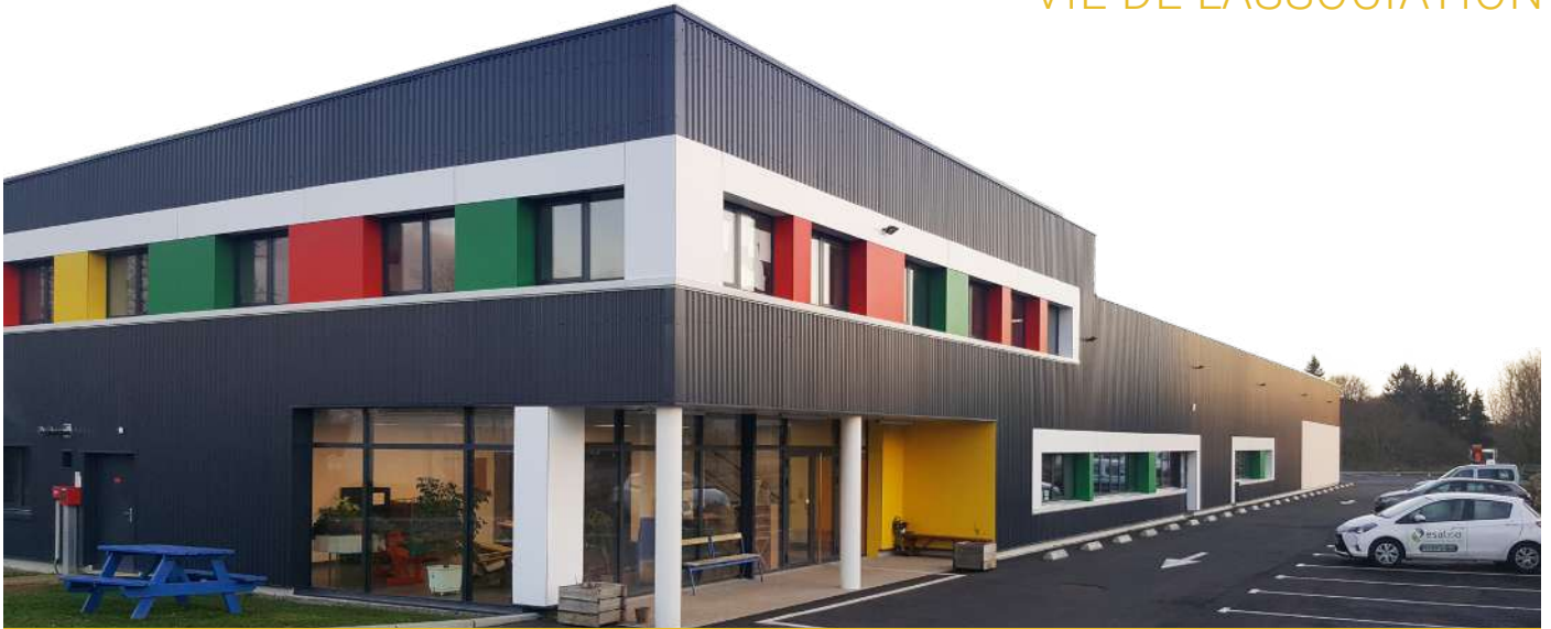
ESAT CORNOUILLE - LA LANDE : BÂTIMENT À COLGUEN
